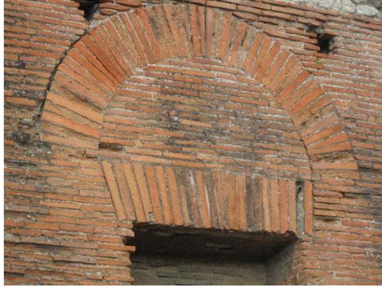
[image 12] à Rome : pavement (briques verticales agencées à angle droit) + à droite : cœur du mur (petits blocs noyés dans le mortier) encastré dans un parement en mortier grisâtre sur lequel a été appliqué un épais enduit (tranche blanchâtre) = petit air des citernes du Pic de Luc-en-Diois ...
