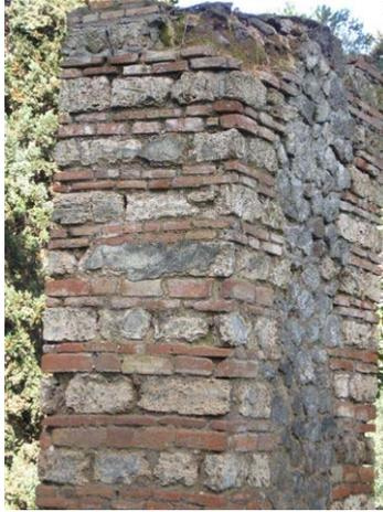
Chânage horizontal en briques (6) au sein d'un mur en pierre [image 08]
