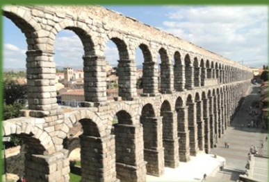
L'AQUEDUC (I er siècle av. J.-C.)
