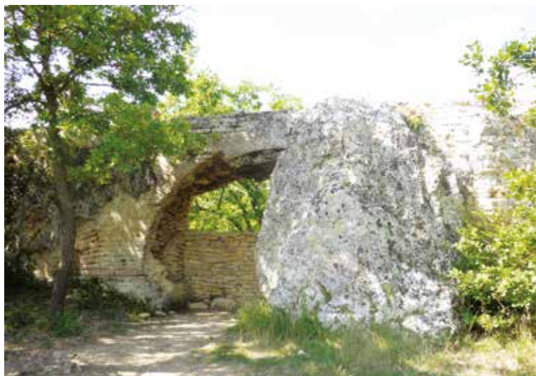
Vestige de la canalisation au lieu-dit « Pont Rou » avec concrétion calcaire externe due à une piqûre* - © Sylvie BORRELLY
